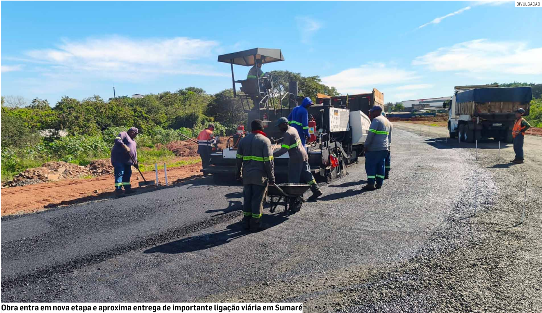
Obra entra em nova etapa e aproxima entrega de importante ligação viária em Sumaré
