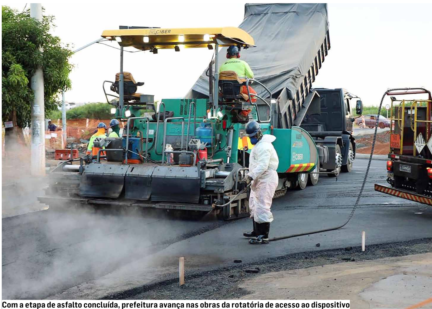
Com a etapa de asfalto concluída, prefeitura avança nas obras da rotatória de acesso ao dispositivo
