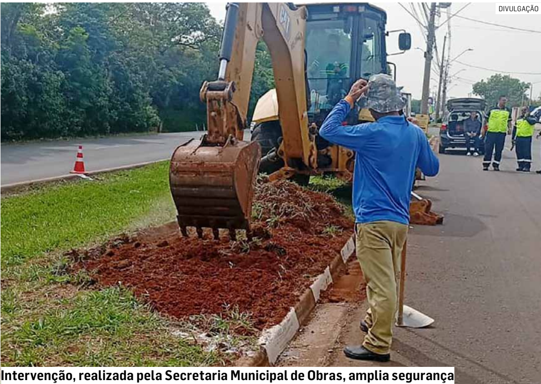
Intervenção, realizada pela Secretaria Municipal de Obras, amplia segurança
