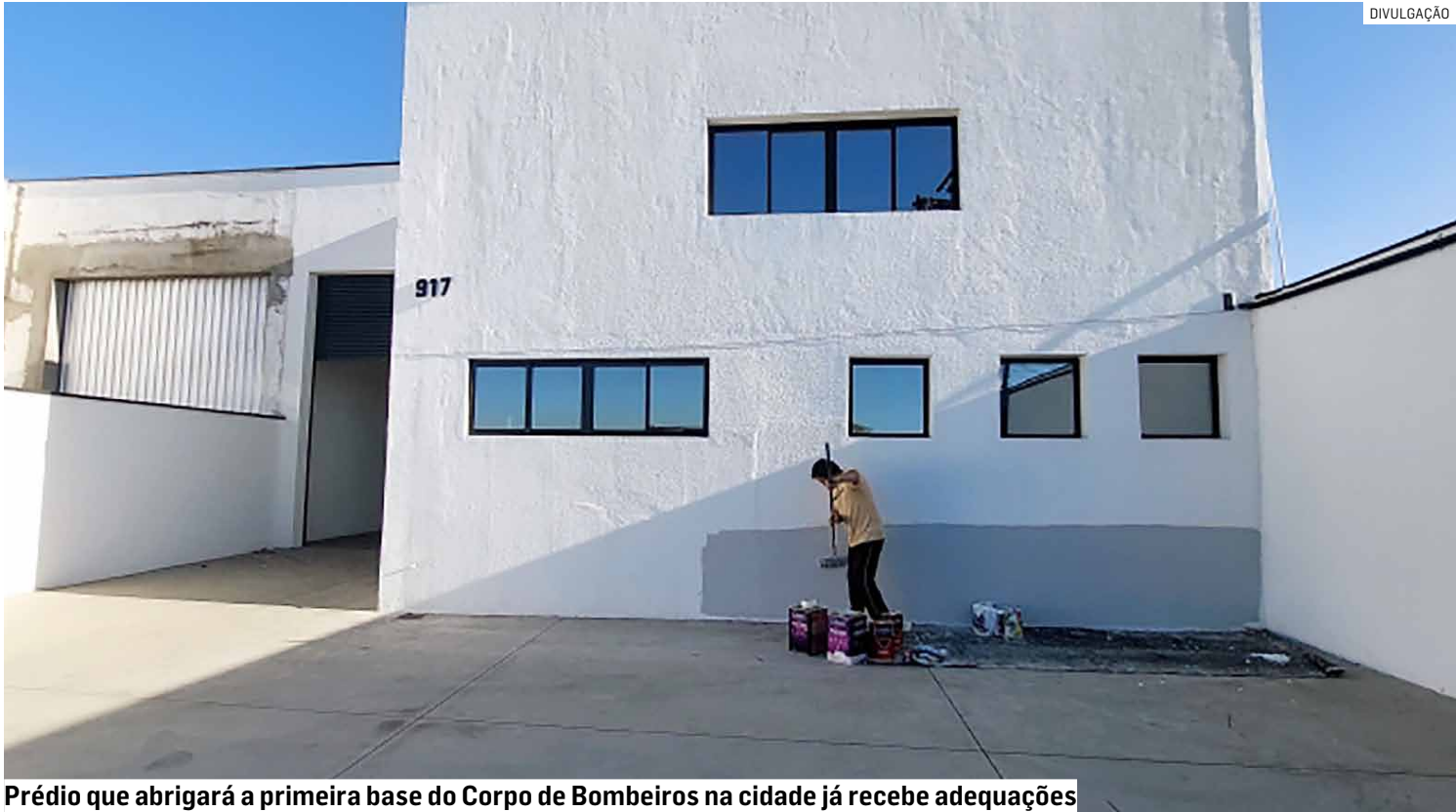
Prédio que abrigará a primeira base do Corpo de Bombeiros na cidade já recebe adequações
