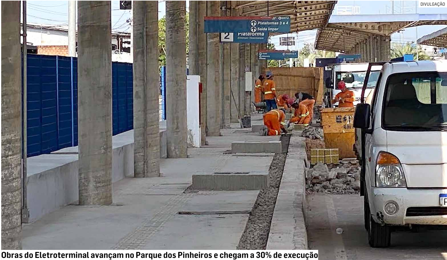
Obras do Eleetroterminal avançam no Parque dos Pinheiros e chegam a 30% de execução
