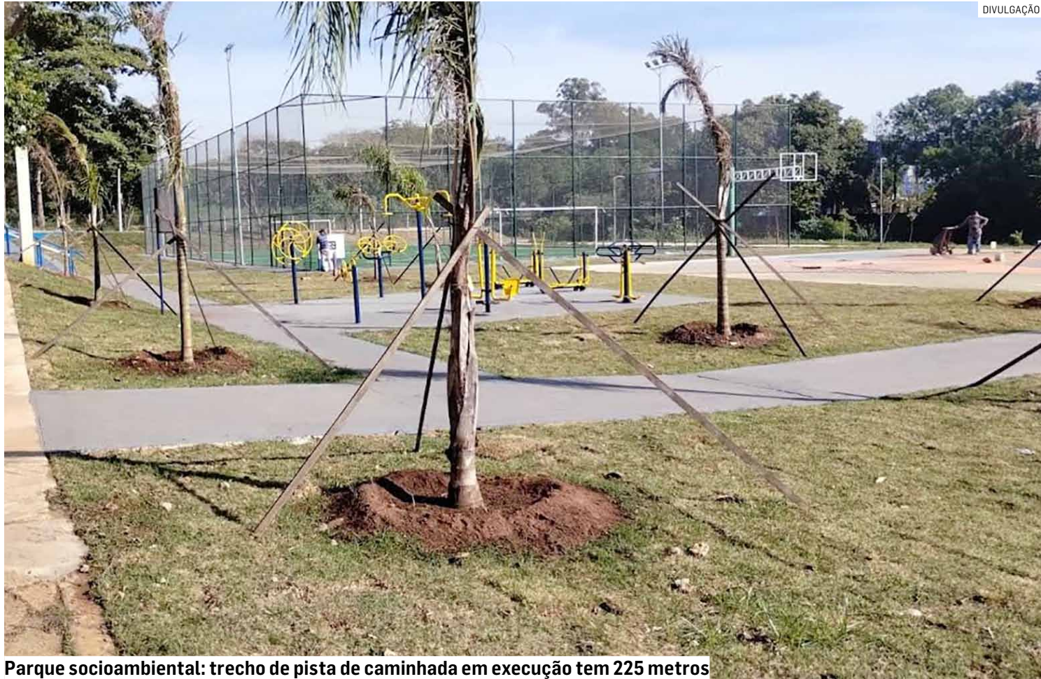
Parque socioambiental: trecho de pista de caminhada em execução tem 225 metros
