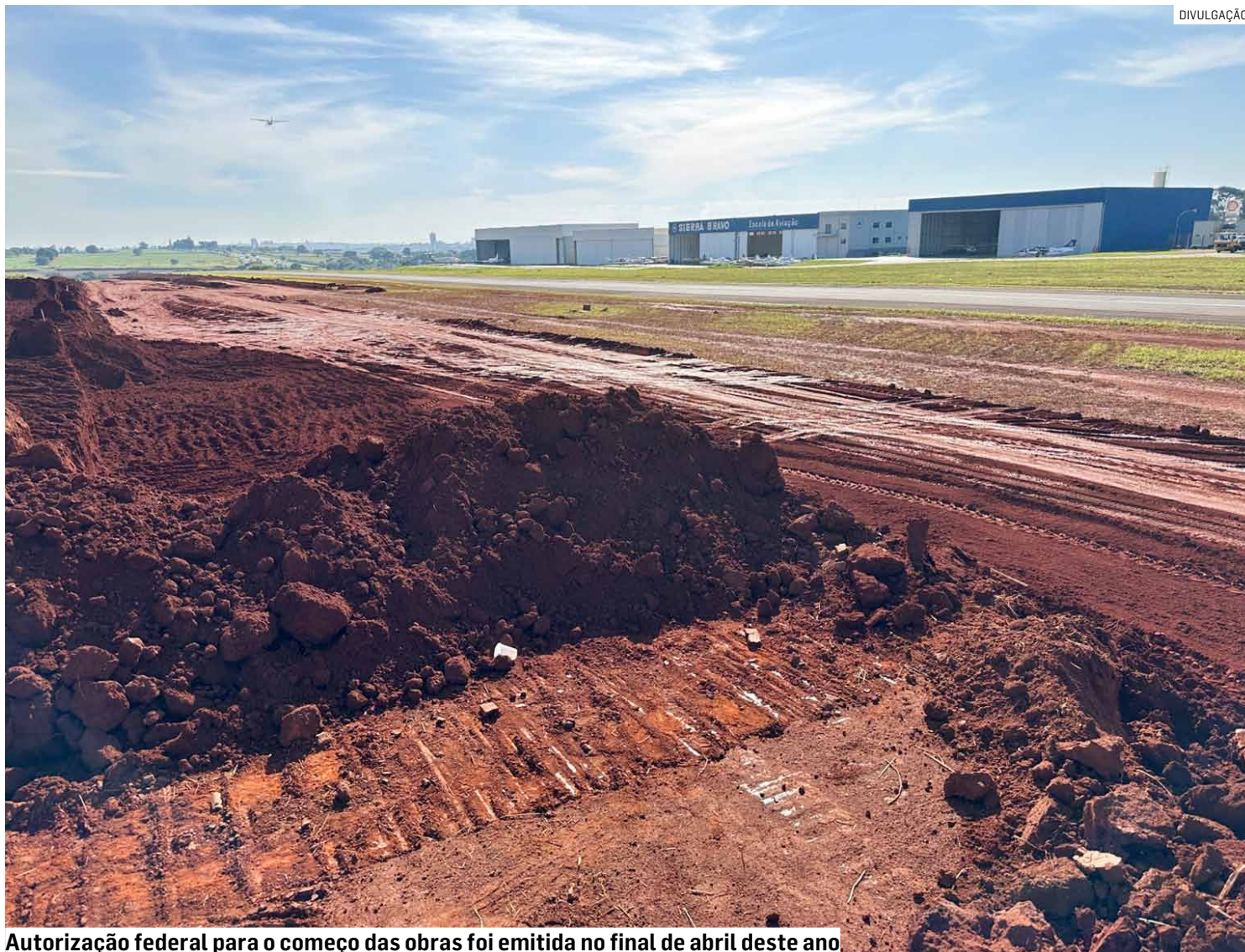
Autorização federal para o começo das obras foi emitida no final de abril deste ano
