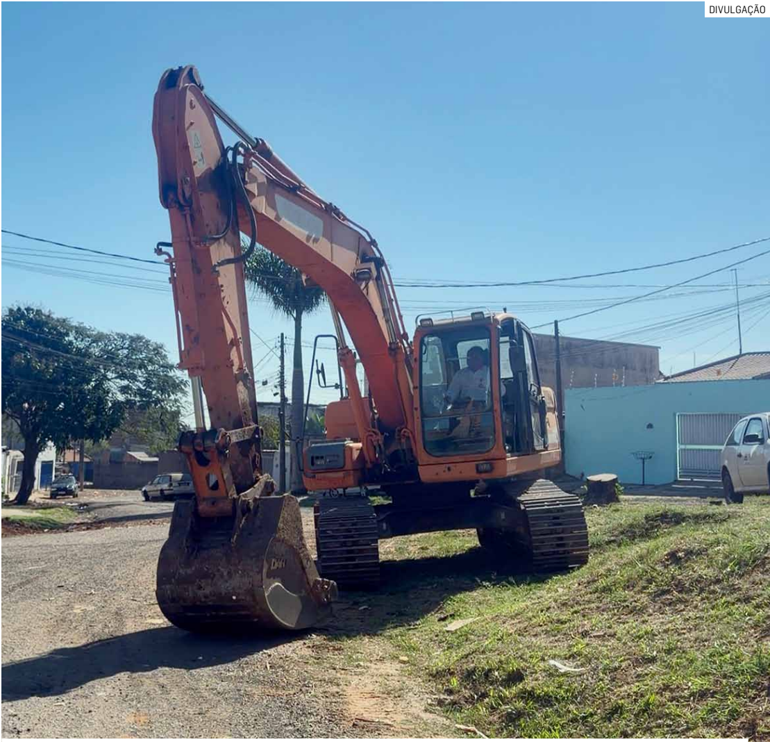
Obra de R$ 8 milhões levará pavimentação completa às ruas da Vila Operária, em Sumaré
