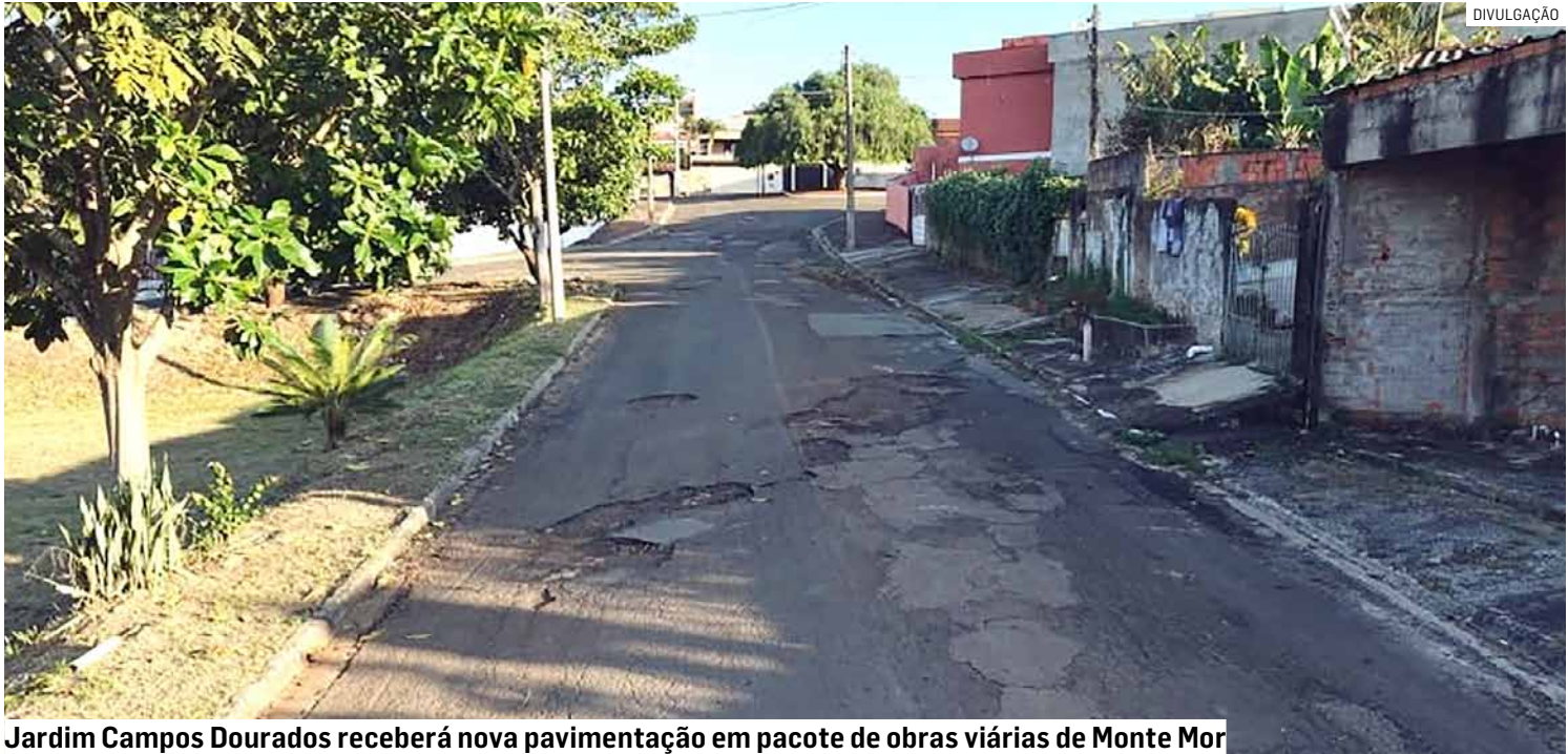
Jardim Campos Dourados receberá nova pavimentação em pacote de obras viárias de Monte Mor
