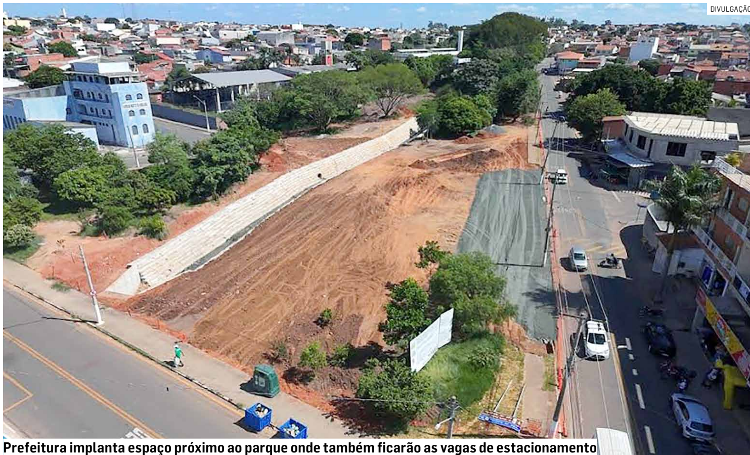
Prefeitura implanta espaço próximo ao parque onde também ficarão as vagas de estacionamento
